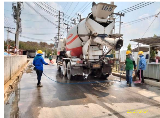
รูปที่ 5 การล้างล้อรถบรรทุกก่อนออกจากพื้นที่ก่อสร้าง
